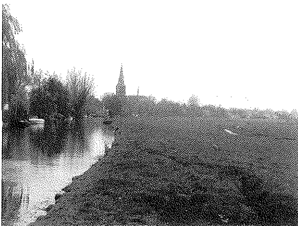
Veendijk langs de ringvaart te Wilnis gezien vanaf de ophaalbrug in de Wilnisse zijweg richting Mijldrecht. Deze dijk is dezelfde dijk waarvan in augustus 2003 nabij de dorpskern een deel afschoof. De dijk dateert van ca. 1874 toen de polder Groot Wilnis-Vinkeveen werd droogemalen. Op de achtergrond de r.k. kerk te Mijldrecht.
