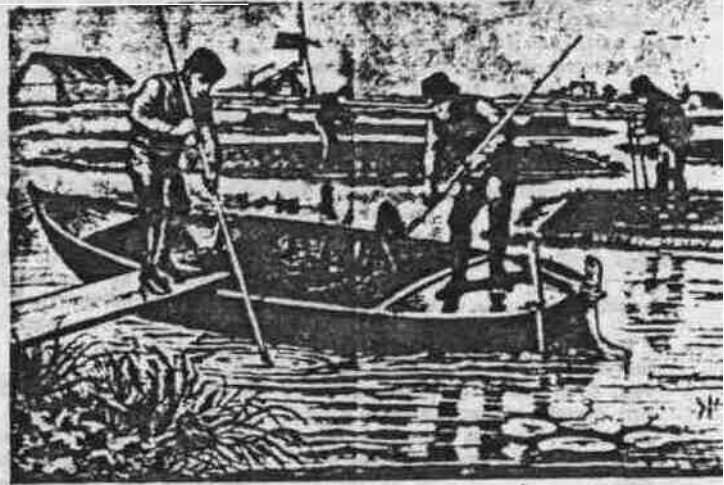
ARBEIDERS AAN HET werk in het laagveen-gebied
