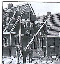
Nieuwbouw in crisistijd
