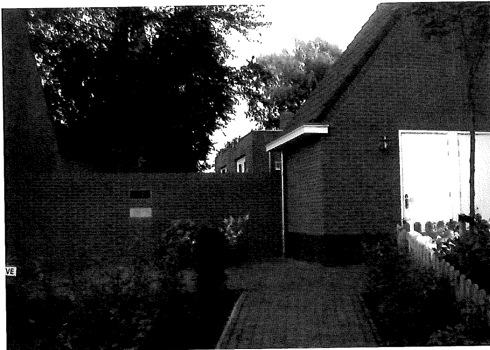
De verbindingsmuur aan Kerkgaarde met daarin de twee stenen.
