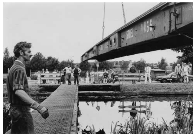
De plaatsing van de tijdelijke brug voor de Coöperatie.
