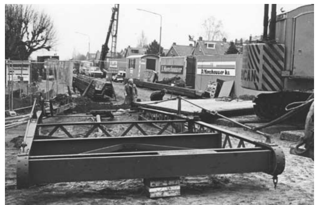
Bovenbouw Hulksbrug ligt klaar voor transport
