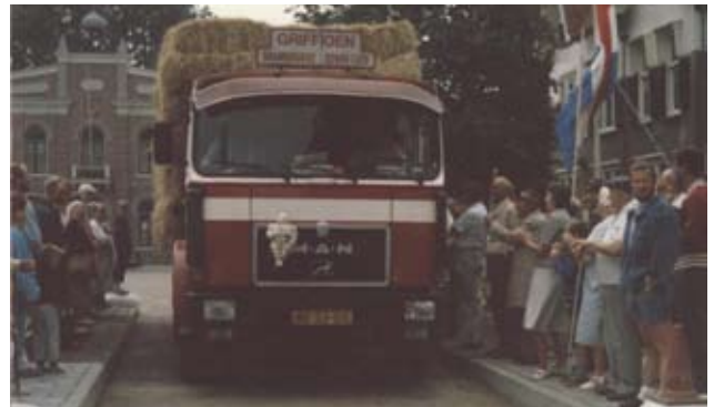
Eerste voertuig passeert de nieuwe Hulksbrug
