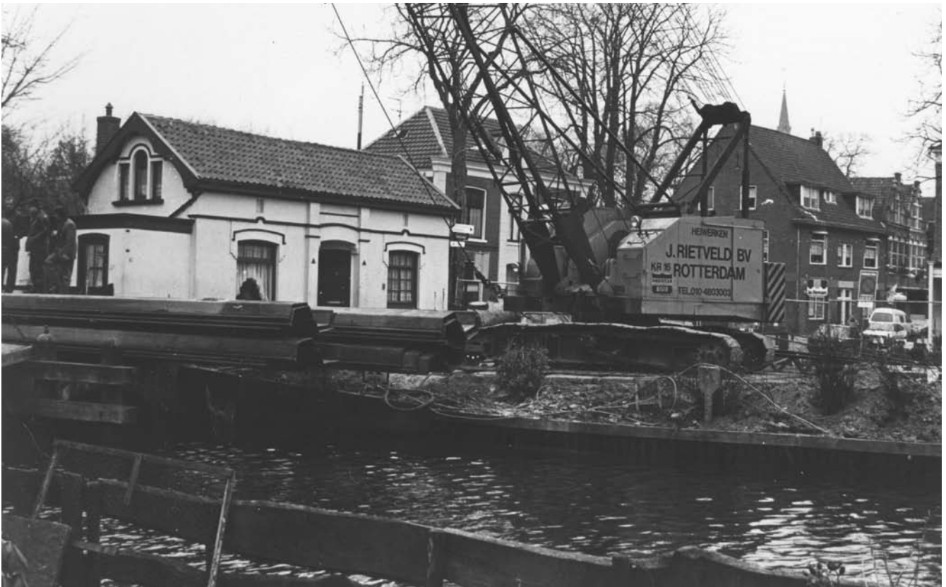
Vorbereidende werkzaamheden demontage vliegtuigbom bij de Hulksbrug
