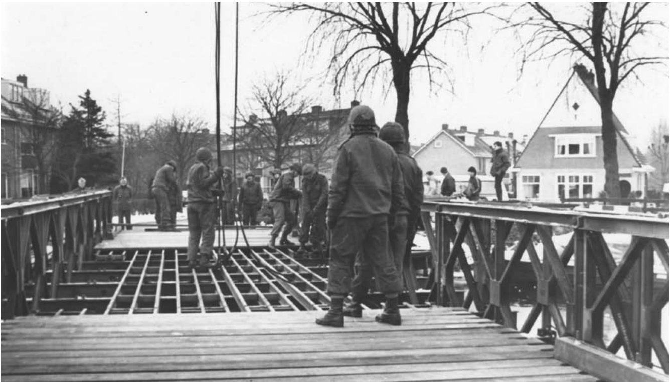
Plaatsen noodbrug door de genie over de Angstel
